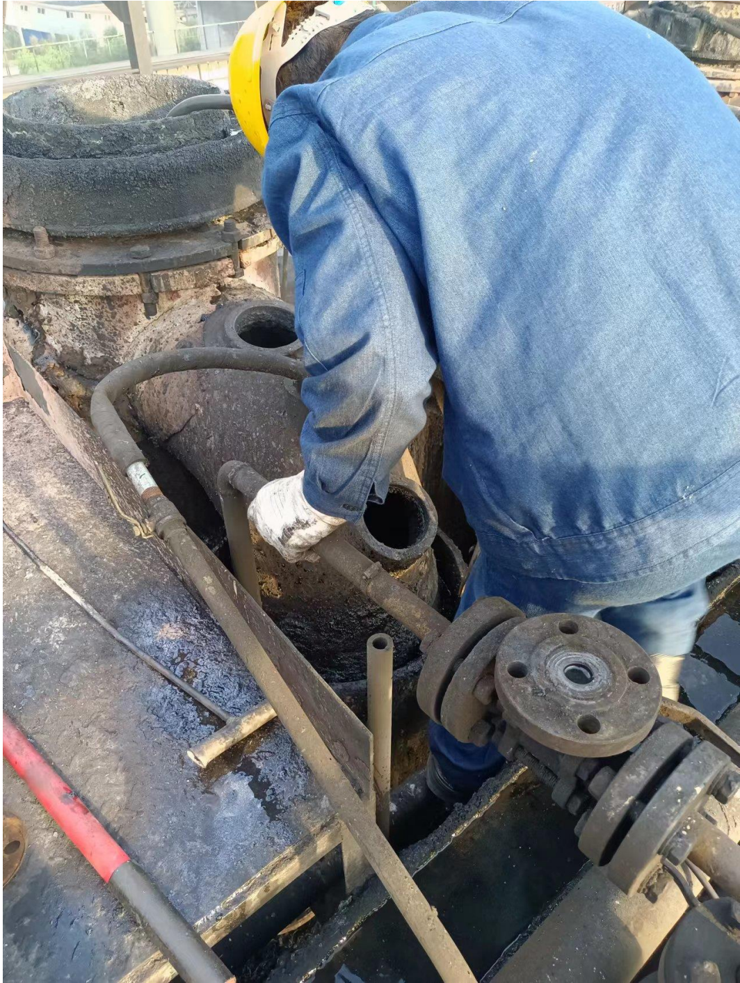
上升管、桥管更换
